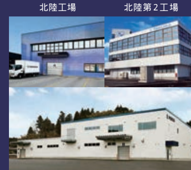
北陸第3工場 <新設>
